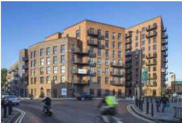
Figura 7. Dalston Lane, el edificio de paneles CLT más alto del Mundo. Fuente: (Schuler Timothy A., 2018)
