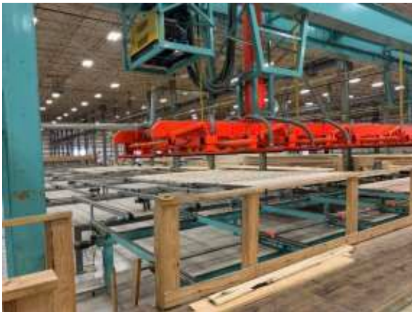
Figura 4. Sistema de apilado por vacío para configurar las capas de paneles CLT
