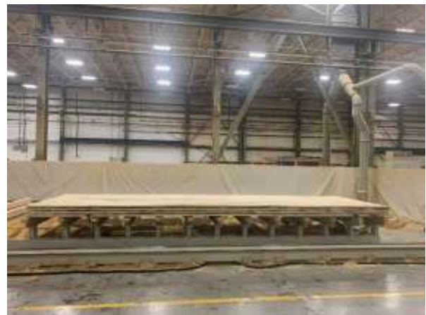
Figura 5. Panel de CLT siendo retirado de la prensa y listo para maquinado en máquina CNC
