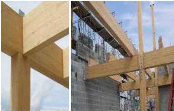
Figure 6: Glulam usado como columna y viga. Fuente: (Anthony Forest Products Co., 2021; CE Center, 2020)
