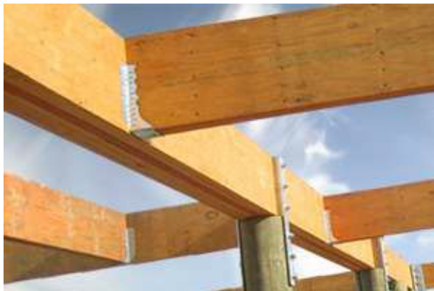
Figura 1: Aplicación estructural de SCL. Fuente (APA, 2021).
